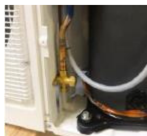
Obr.17 Servisní ventil
